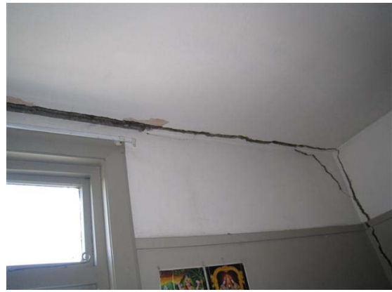
(d) Internal view showing wall separation
