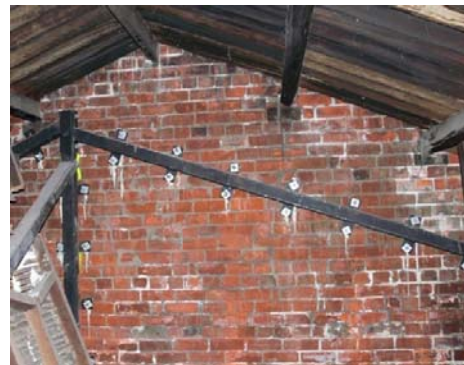
(d) gable strengthening
