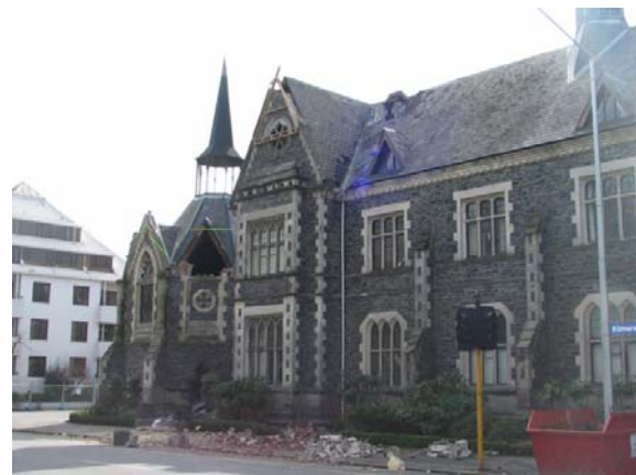
(d) Kilmore-Montreal street corner
