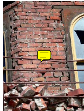
(d) Metal wall ties badly deformed.
